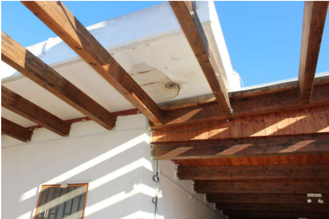
Foto n°68 Degrado delle coperture.
