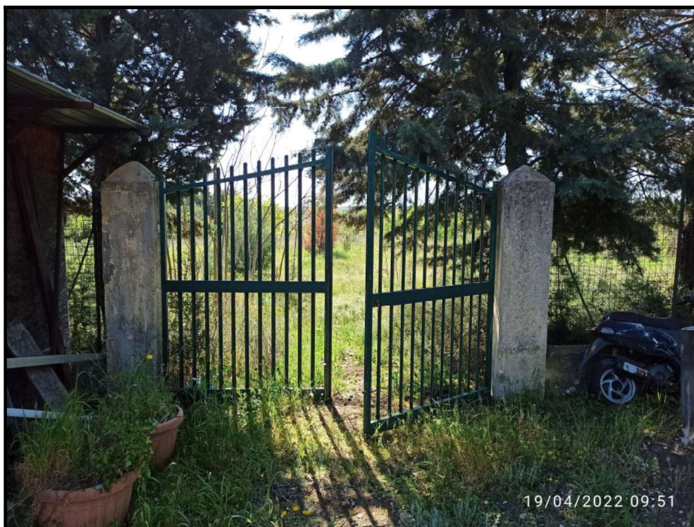
Fot. 14 – Ingresso terreno retrostante –
