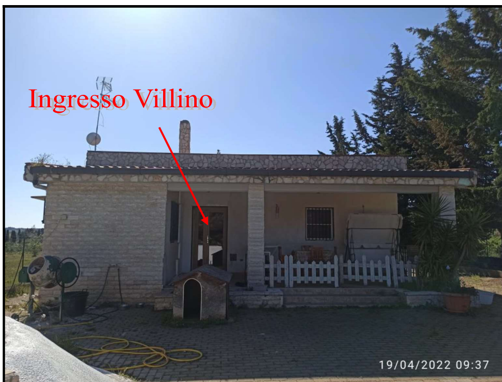
Fot. 2 – Ingresso Villino –
