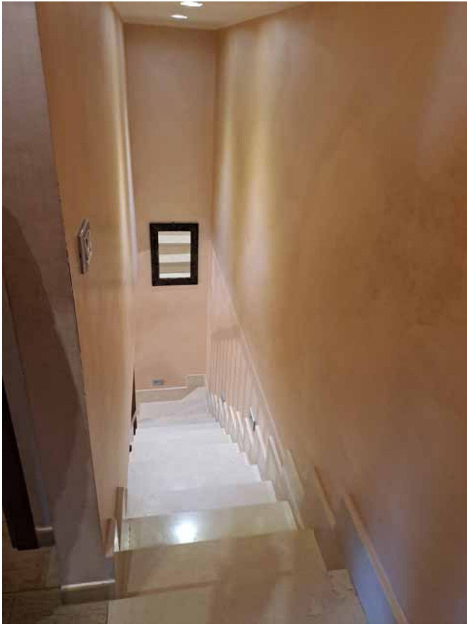
Figura 9 - scala di accesso al primo piano
