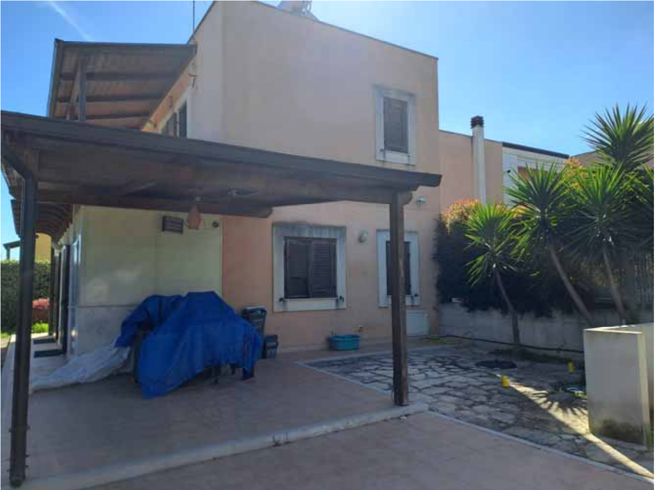
Figura 21 - area esterna con zona di parcheggio (lato ovest)
